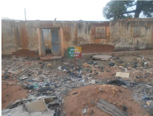
Photo 2 : Domaine public occupé illégalement à Bantè
